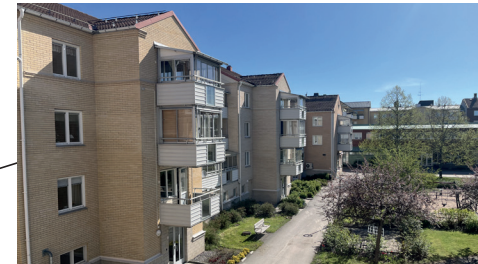
Rosenbusken 12, Djulöгатan 23, Kungsgatan 11-13, Fredsgatan 20
